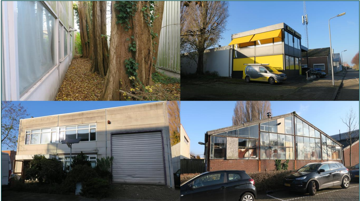
Figuur 1.2 In het plangebied staan verscheidene soorten bebouwing. Alle bebouwing wordt gesloopt ten behoeve van herontwikkeling.
