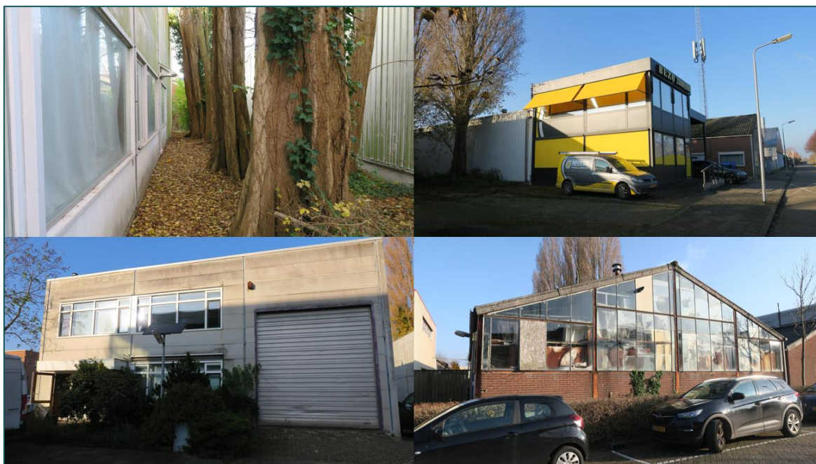
Figuur 1.3 Deel D bestaat uit verscheidende bedrijfsgebouwen en een groenstrook.
