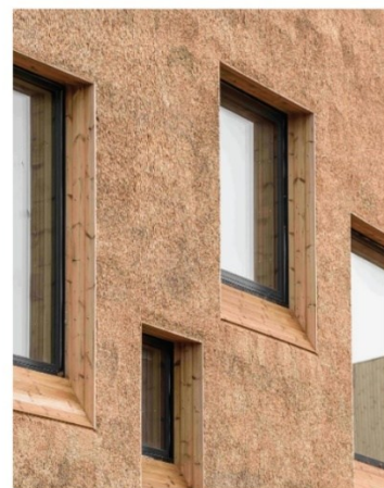
Inpassen van biobased materialen in gevel
