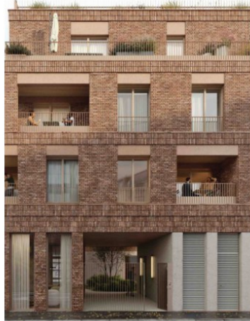
Subtiel leesbare opbouw
