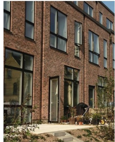
Verticale segmentatie om wandvorming te voorkomen
