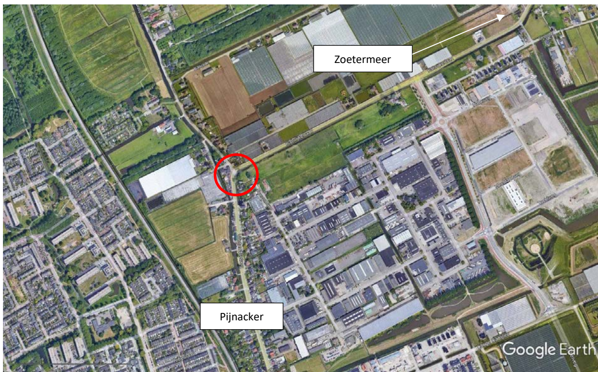
Figuur 3.1: Luchtfoto huidige situatie
