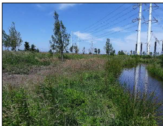
Afbeelding 2: Zicht op watergang langs braakliggend terrein en hoogspanningsmasten.
