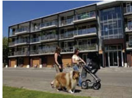
Gereneveerde flat in Pijnacker Noord
